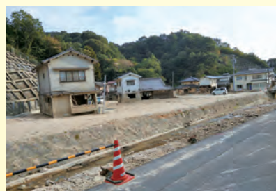
今でも更地に廃墟化した家が残る 小屋浦地区
